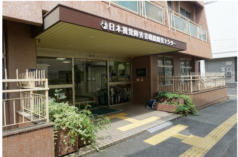
日本視覚障害者職能開発センター 外観
