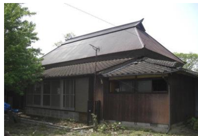
古い民家をお借りして改修工事をおこなっています。
